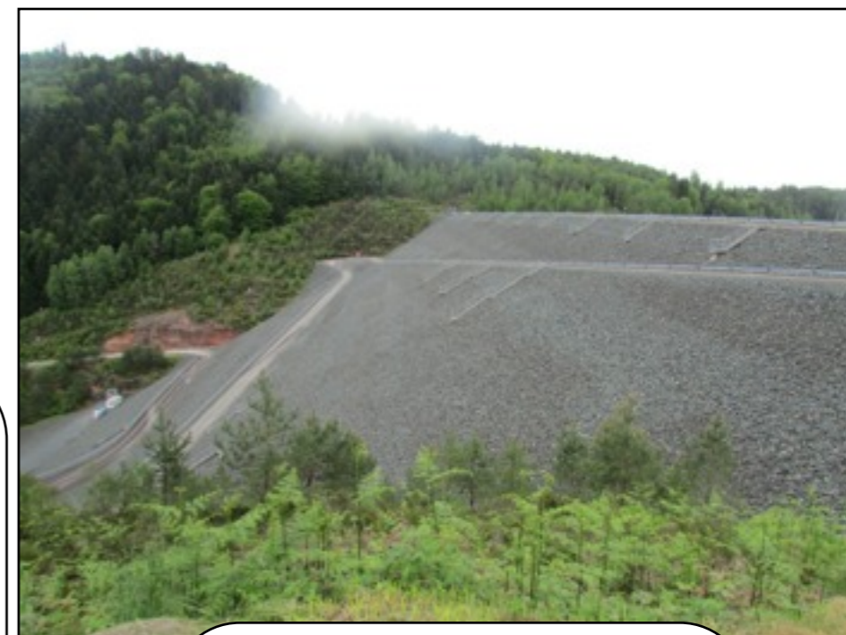
le barrage est haut de 78m
